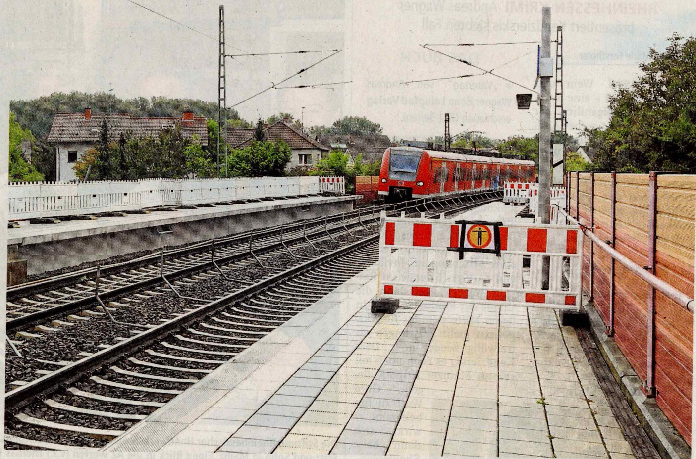
Am Bahnhaltelpunkt in Nackenheim werden derzeit die Bahnsteige um 46 Meter auf 210 Meter verlängert.
